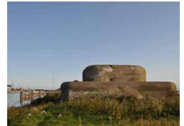
Kazemat bij Kornwerderzand
